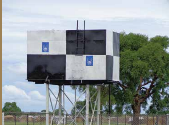
أعلاه: محطة المياه بعد إعادة تأهيلها
